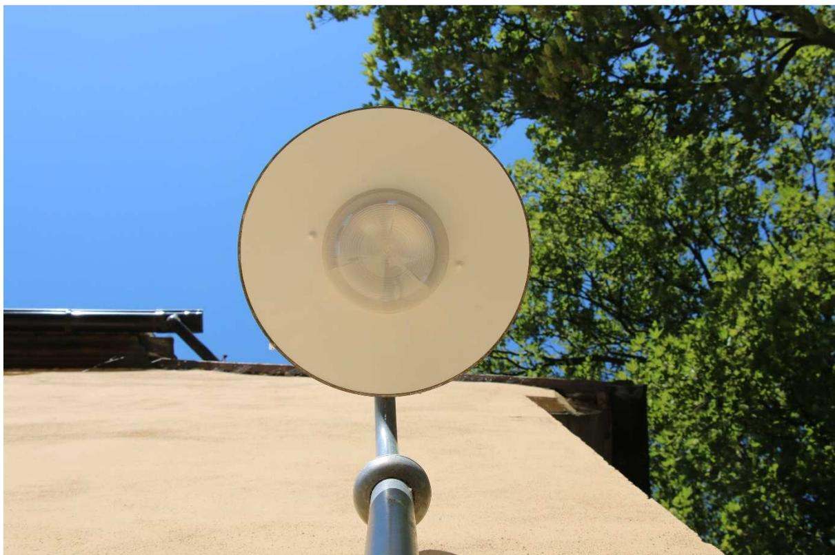
**Abb. 18:** Leuchtstelle 65 nach Umbau mit einem asymmetrisch strahlenden LED – Upgrade Kit (Unteransicht).
