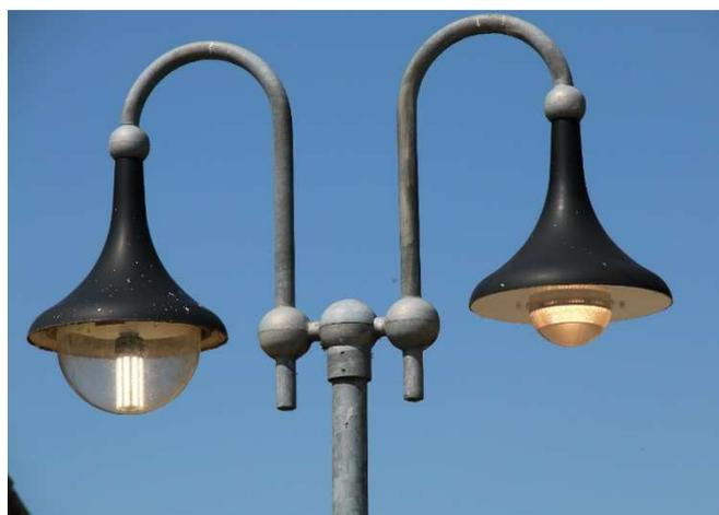
**Abb. 16:** Vergleich einer umgerüsteten Leuchte (rechts) mit einer der aktuellen Bestandssituation (links), Gehofen Leuchte Nr. 68.
